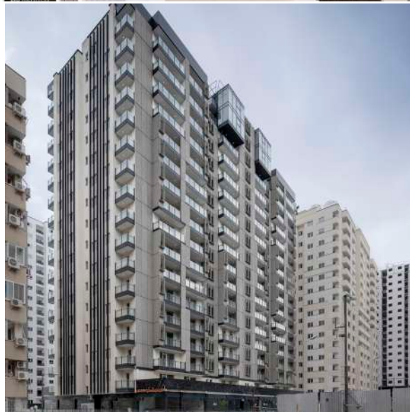
مقایسه دوشیوه ساخت پیش ساخته بتنی و سنتی در دو ساختمان همسایه
