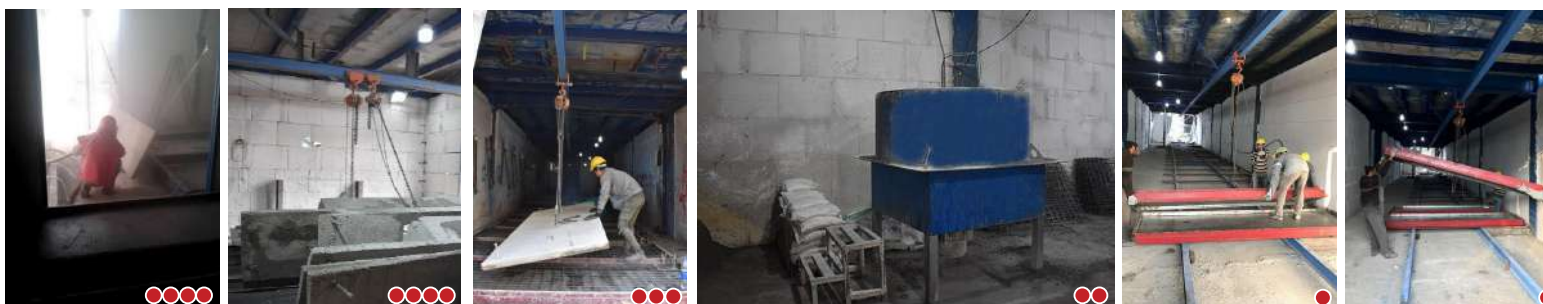
● جانمایی قالبها بر روی شاسیها ● جانمایی بتونیر ●●●●● نصب ریل سقفی ●●●●● ایجاد کارگاه سند بلاست
