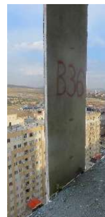
نصب کردن قطعات تیپ ۱، ۲ و ۳
