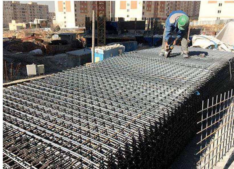
شیت های مش از میلگرد ۸ به فواصل ۱۰ سانتیمتر که از کارخانه به ابعاد 2 \times 4/6 از کارخانه آمده و به ابعاد مورد نظر بریده و شکل داده میشود.
