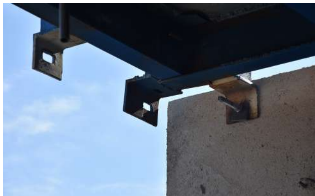
ضدزنگ ناودانی ها و واشرها پس از نصب
