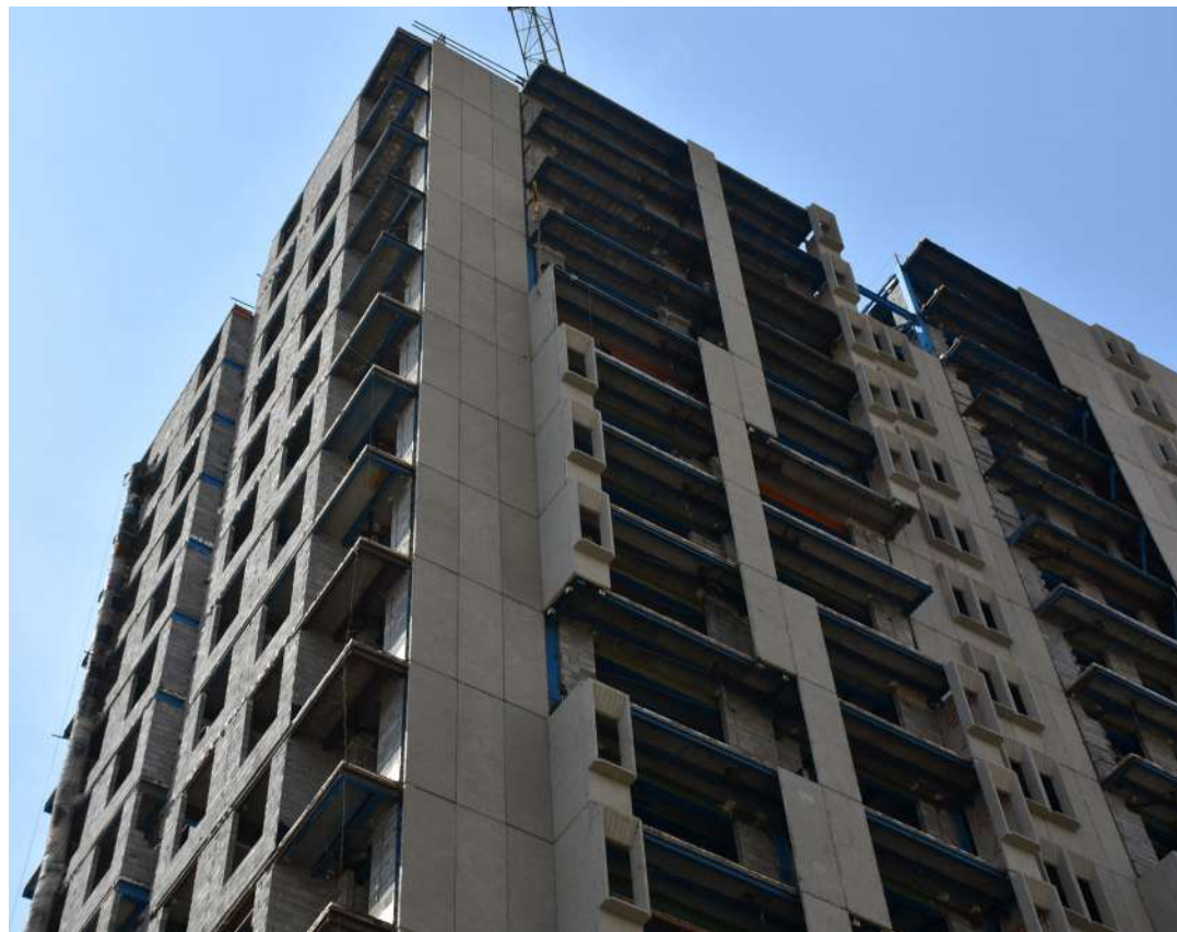
نصب کردن قطعات تیپ ۱، ۲ و ۳
