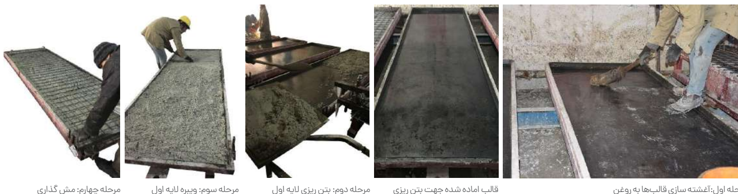
مرحله اول: آغشته سازی قالب ها به روغن قالب آماده شده جهت بتن ریزی مرحله دوم: بتن ریزی لایه اول مرحله سوم: ویبره لایه اول مرحله چهارم: مش گذاری
