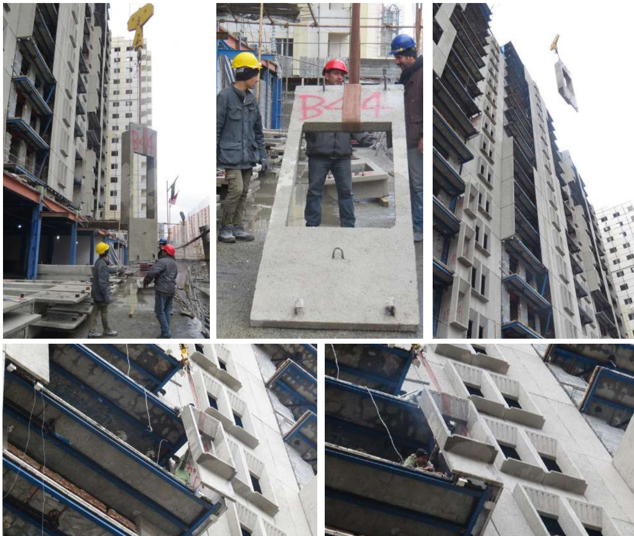
نصب کردن قطعات تیپ ۴
