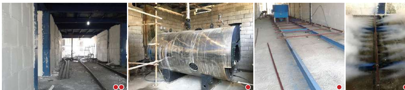
● جانمایی دیگ بخار و لوله کشی جهت بخار رسانی ● شاسی کشی زیر قالبها
