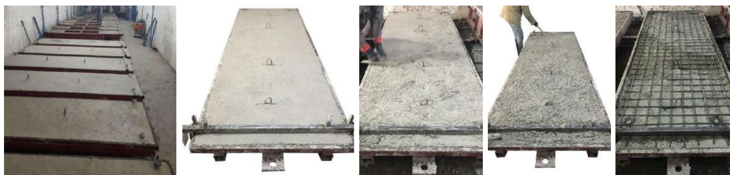
مرحله اول: آغشته سازی قالب ها به روغن قالب آماده شده جهت بتن ریزی مرحله دوم: بتن ریزی لایه اول مرحله سوم: ویبره لایه اول مرحله چهارم: مش گذاری
