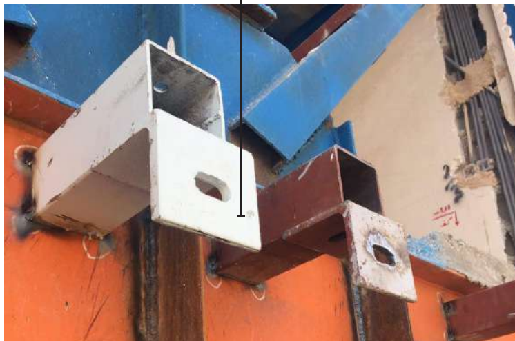
قرارگیری براکت‌ها بر روی نقاط مشخص شده
