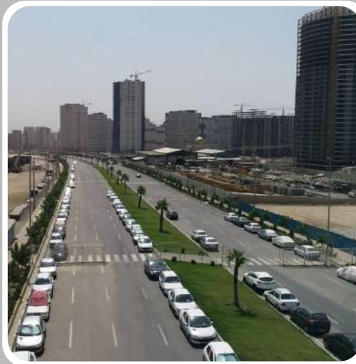
پروژه راهسازی داخلی شهرک مسکونی چیتگر
